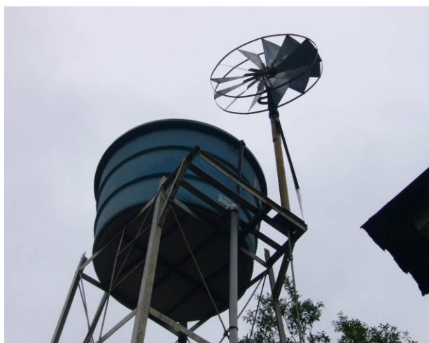
Figura 2: Cata vento utilizado no sistema
